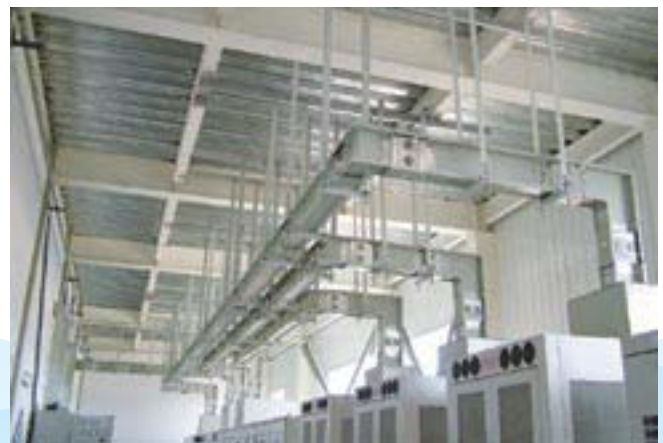
母线设计简单清晰，火灾荷载低
